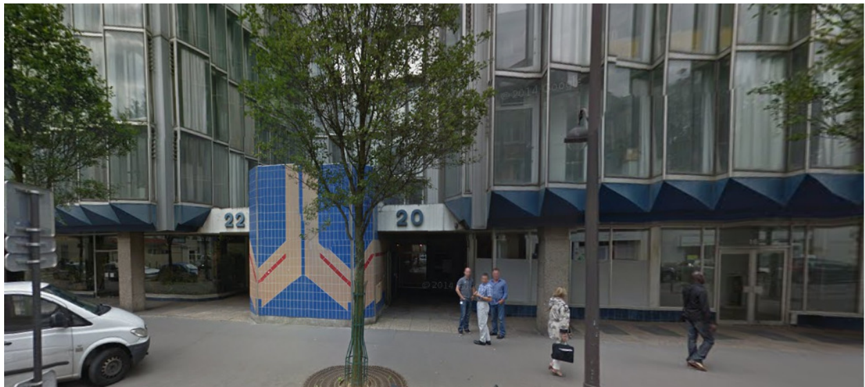
Rue du Château des Rentiers, Paris
